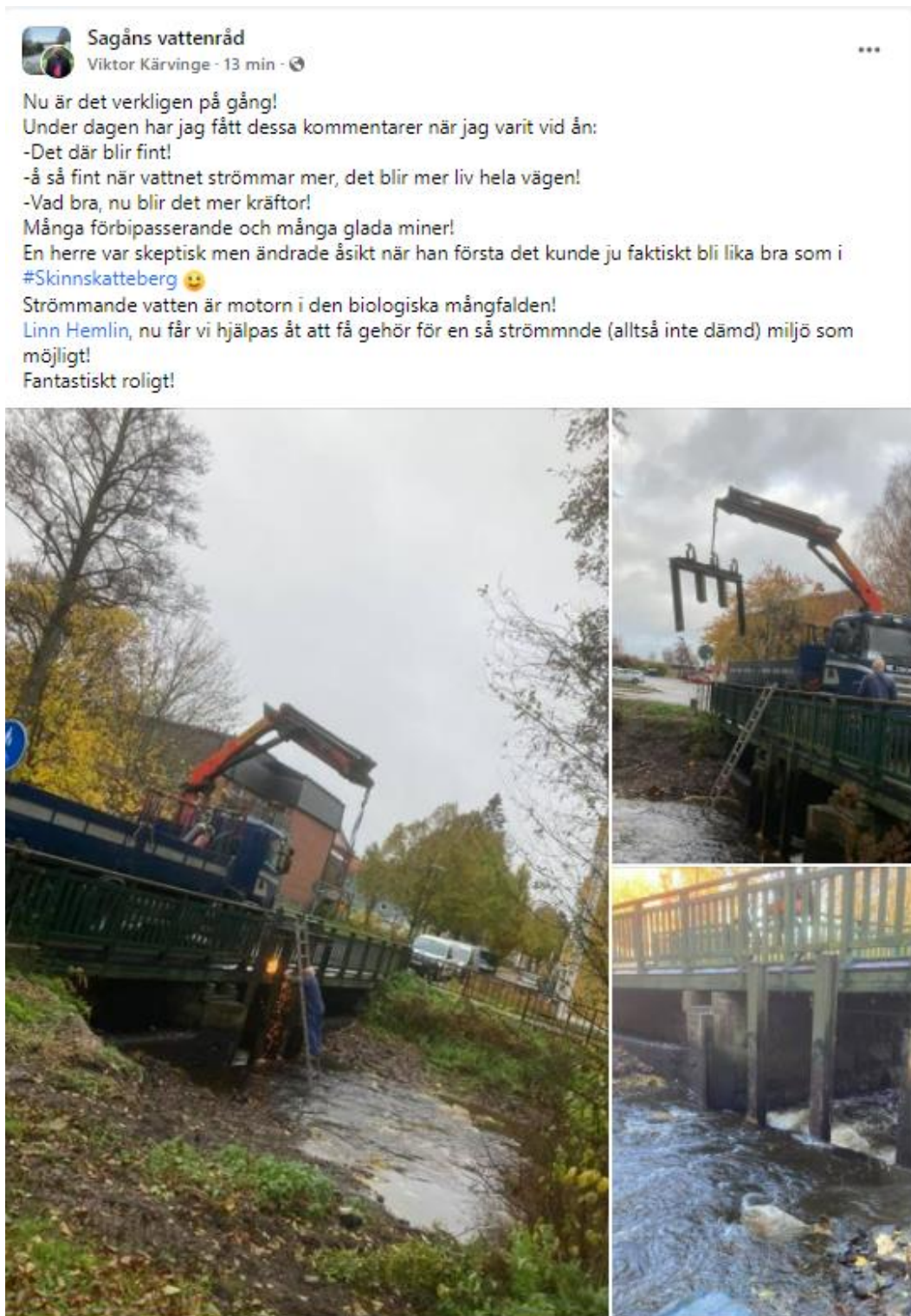
Bild G. Information från Sagans vattenråd angående pågående åtgärder i Lillån, Sala kommun. Foton visar hur dammluckor plockas bort och vattnet strömmar fritt (Inlägg publicerat av Sagans vattenråd på Facebook 2021-10-27).
