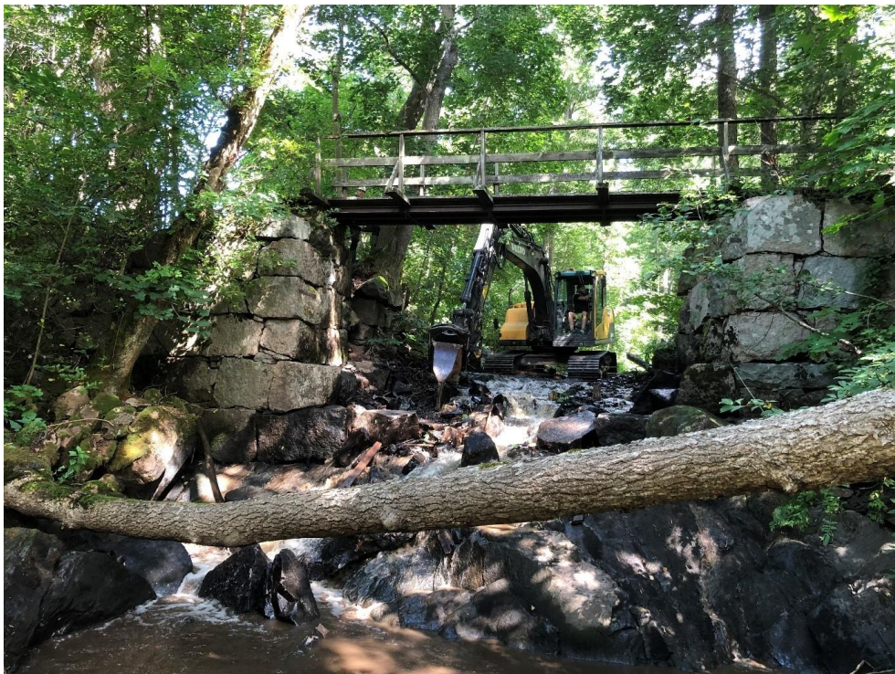
Bild 10. Delsänkning och tröskling av dammen vid Gisslarbo nedrehammare. Foto:Viktor Kärvinge
