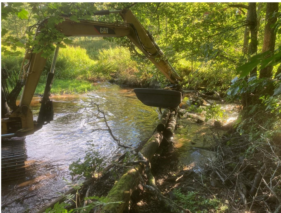
Bild 15 De modernare delarna av dammen plockas bort. Kvarngården. Foto: Viktor Kärvinge
