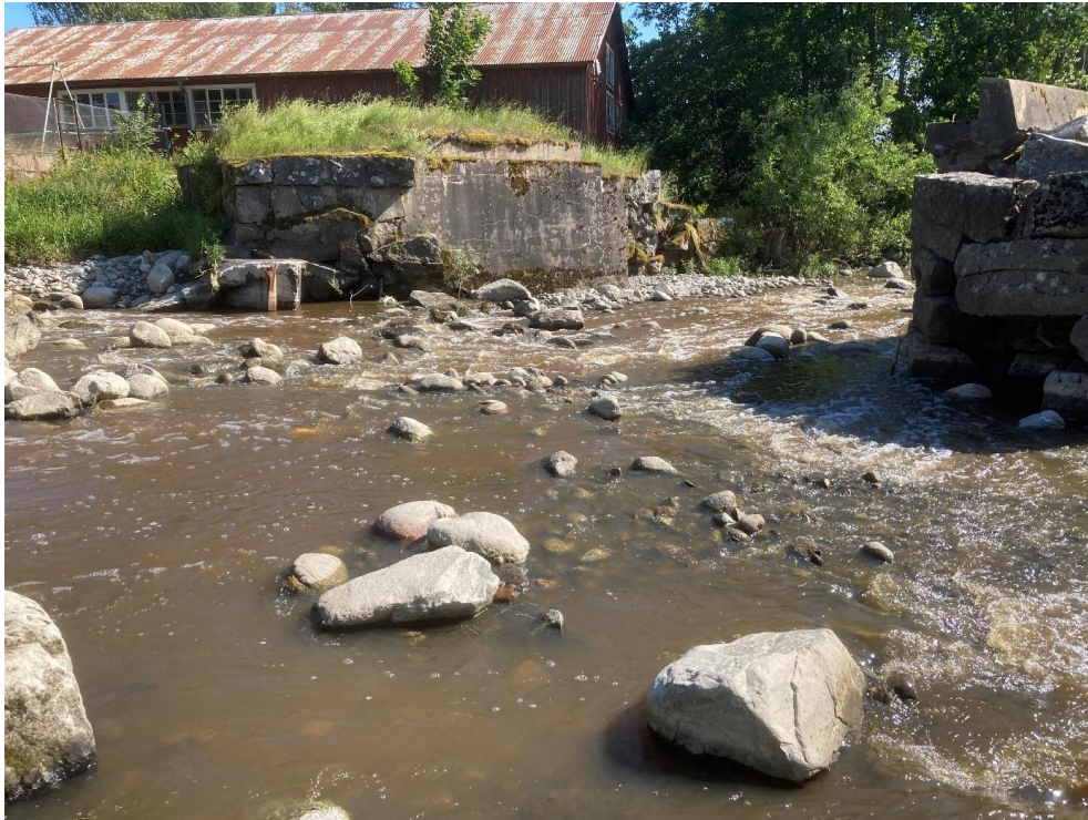
Bild 12. Ny strömnacke och stora delar av den gamla dammen bevarad. Foto: Viktor Kärvinge
