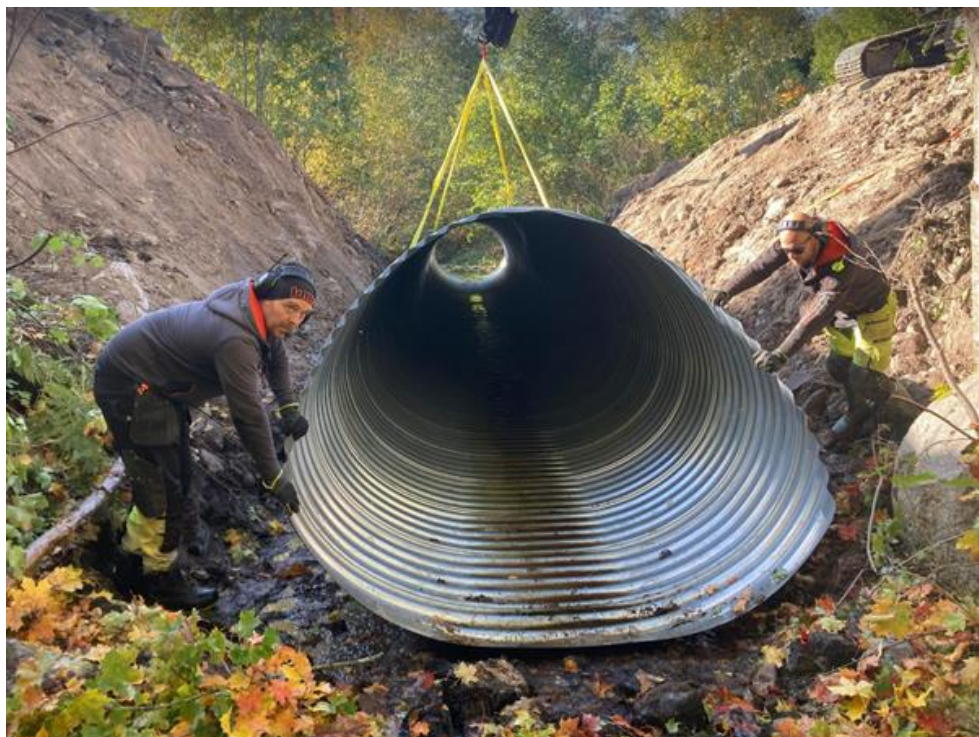
Bild 8 En av de två trummorna läggs på plats. Foto: Malin Kjellin
