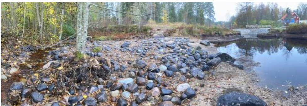
Bild 7 Den nya tröskeln vid Bockhammar innan vattnet släpptes på. Foto:Viktor Kärvinge
