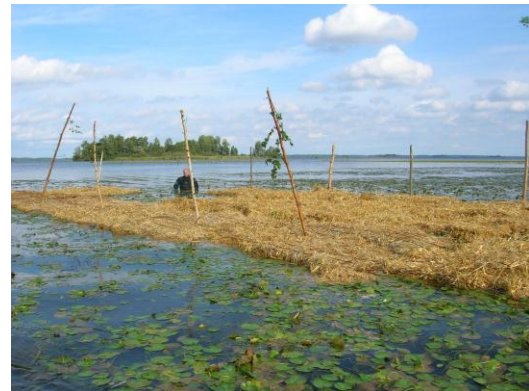
Bild 5: Eftersom halmen flöt till en början trots tyngderna förankrades paketen med käppar i botten.
