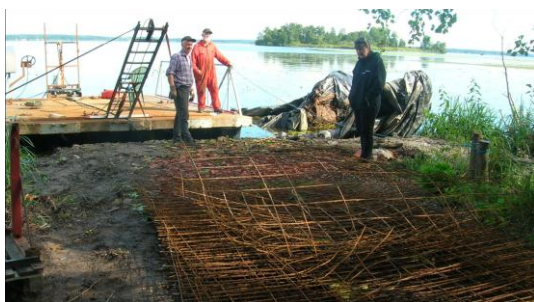
Bild 8: Upptagning av tidigare täckning bestående av plast och armeringsmatta.
