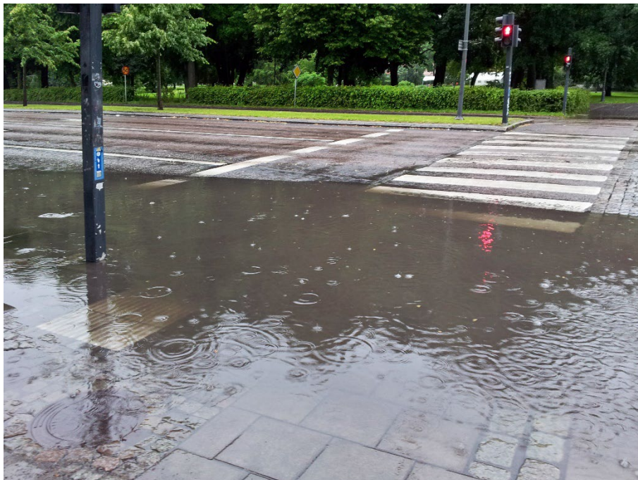
Under 2024 kommer vi att ta fram en redovisning av vårt arbete med dagvatten. Bild: Översvämning i Västerås Foto: Michael Erhardsson, Mostphotos.
